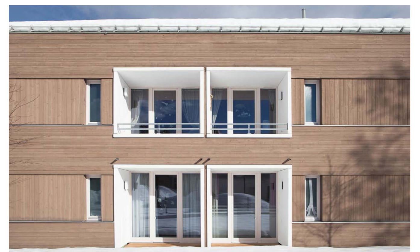
Loggien der Bewohnerzimmer © Steinert Architekten GmbH
