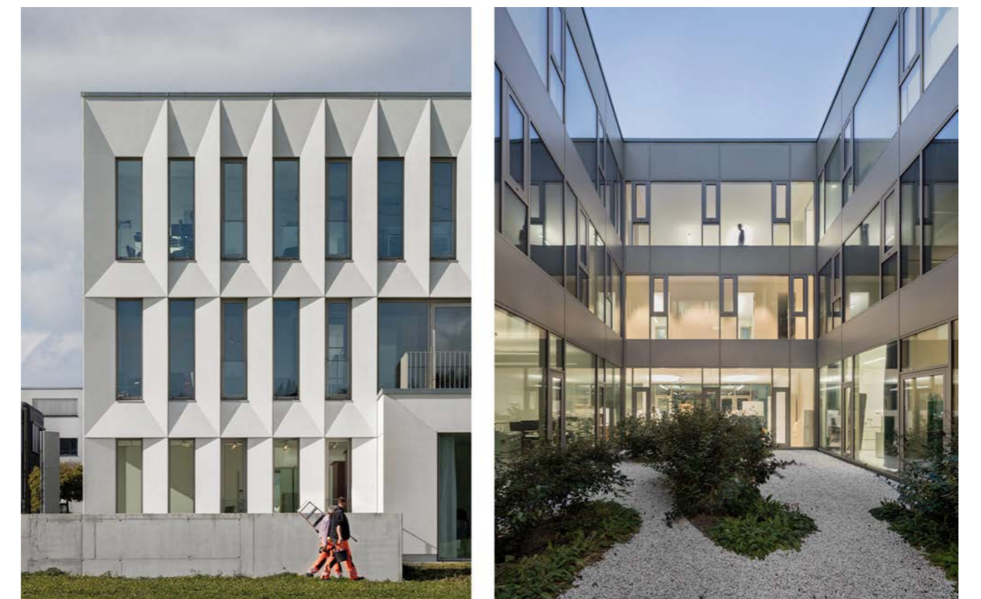
Fassade und Innenhof © Werner Huthmacher
