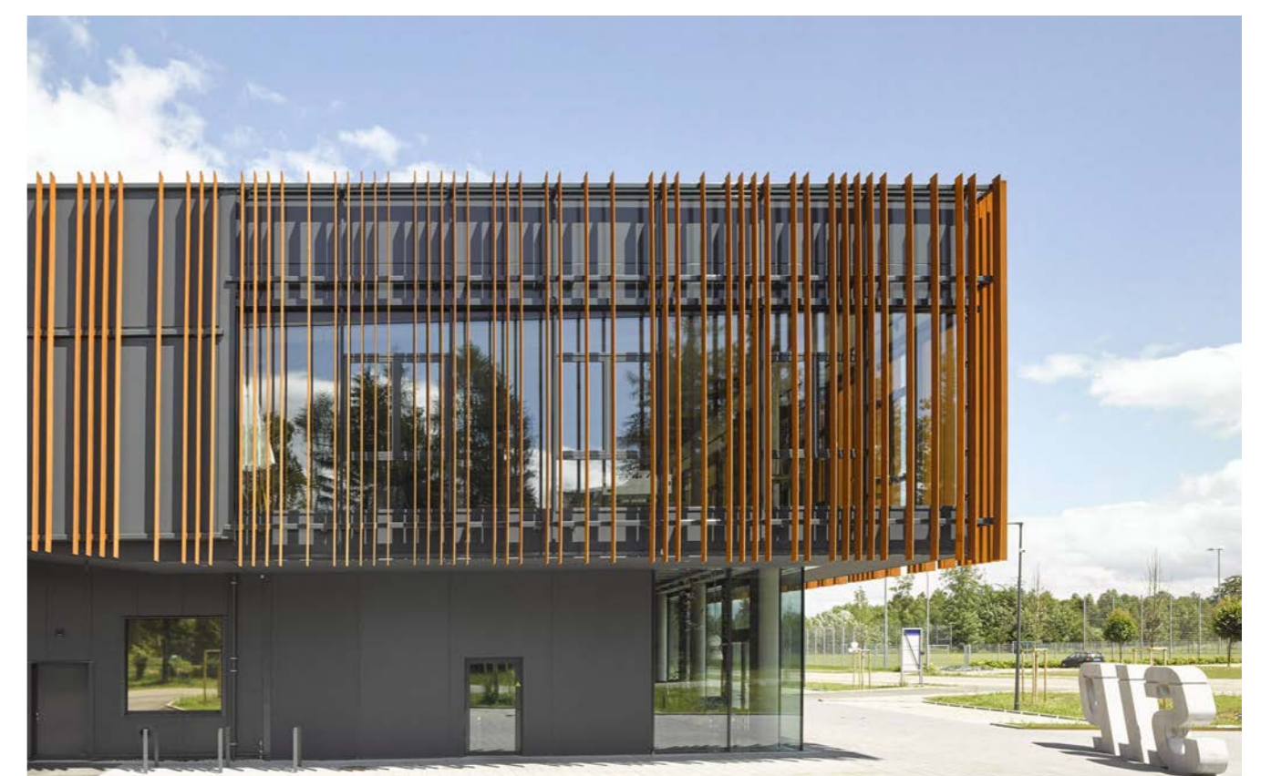
Ansicht von Westen © David Matthiesen
