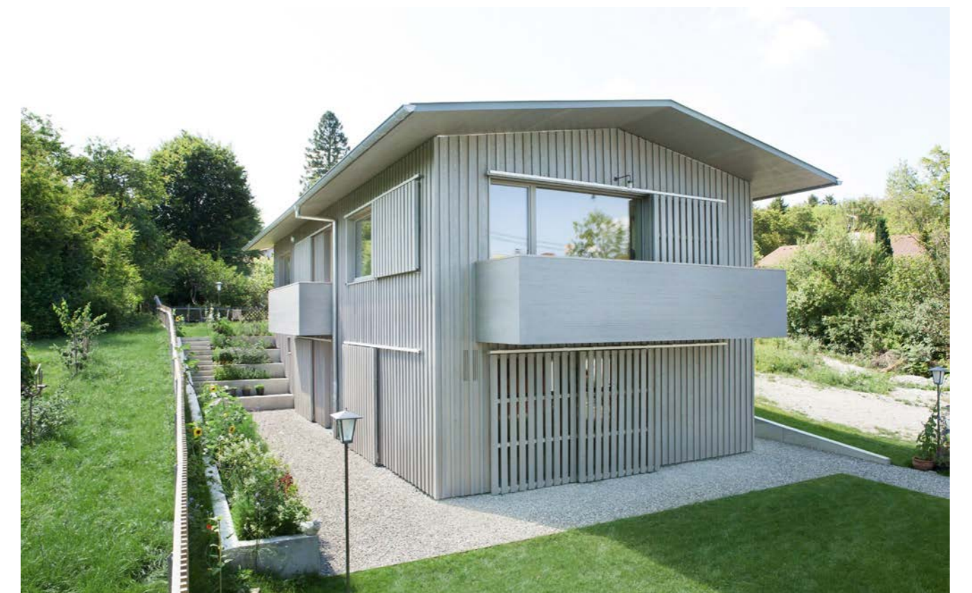
Süd-Ostfassade © Caro Dentler
