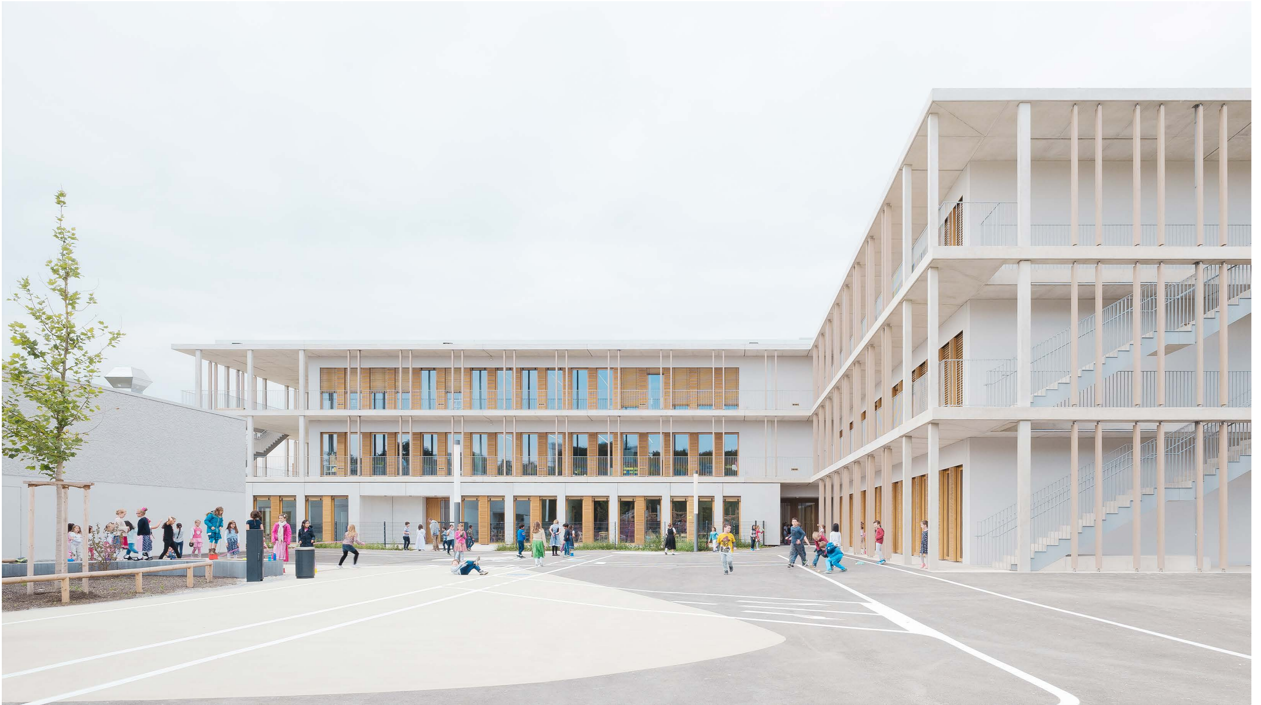
Blick über den Pausenhof zum Schuleingang © Brigida González für wulf architekten
