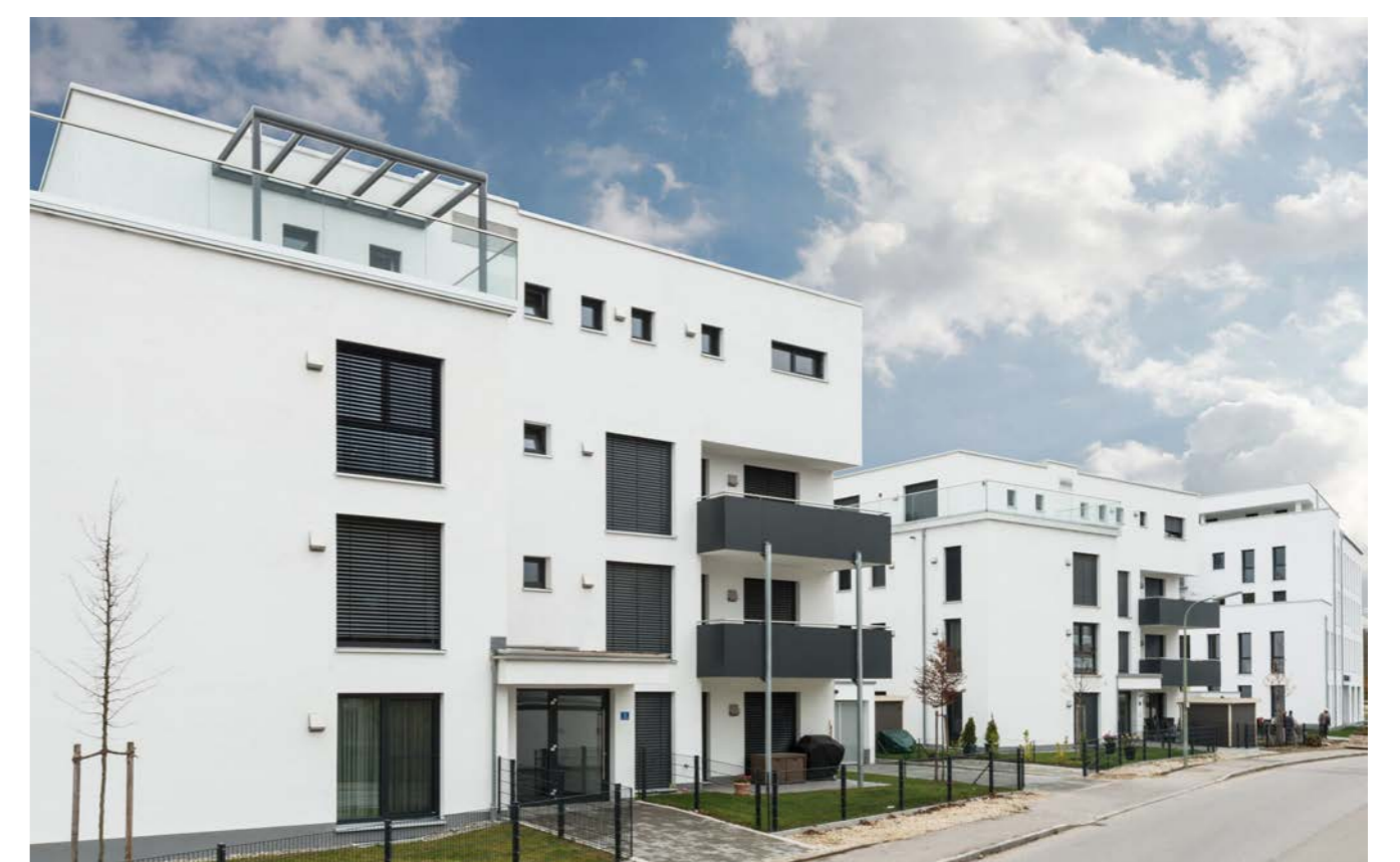
Ansicht im Straßenverlauf © Danny Rothe, Bahnhofstraße 17-19, 82418 Murnau a.
