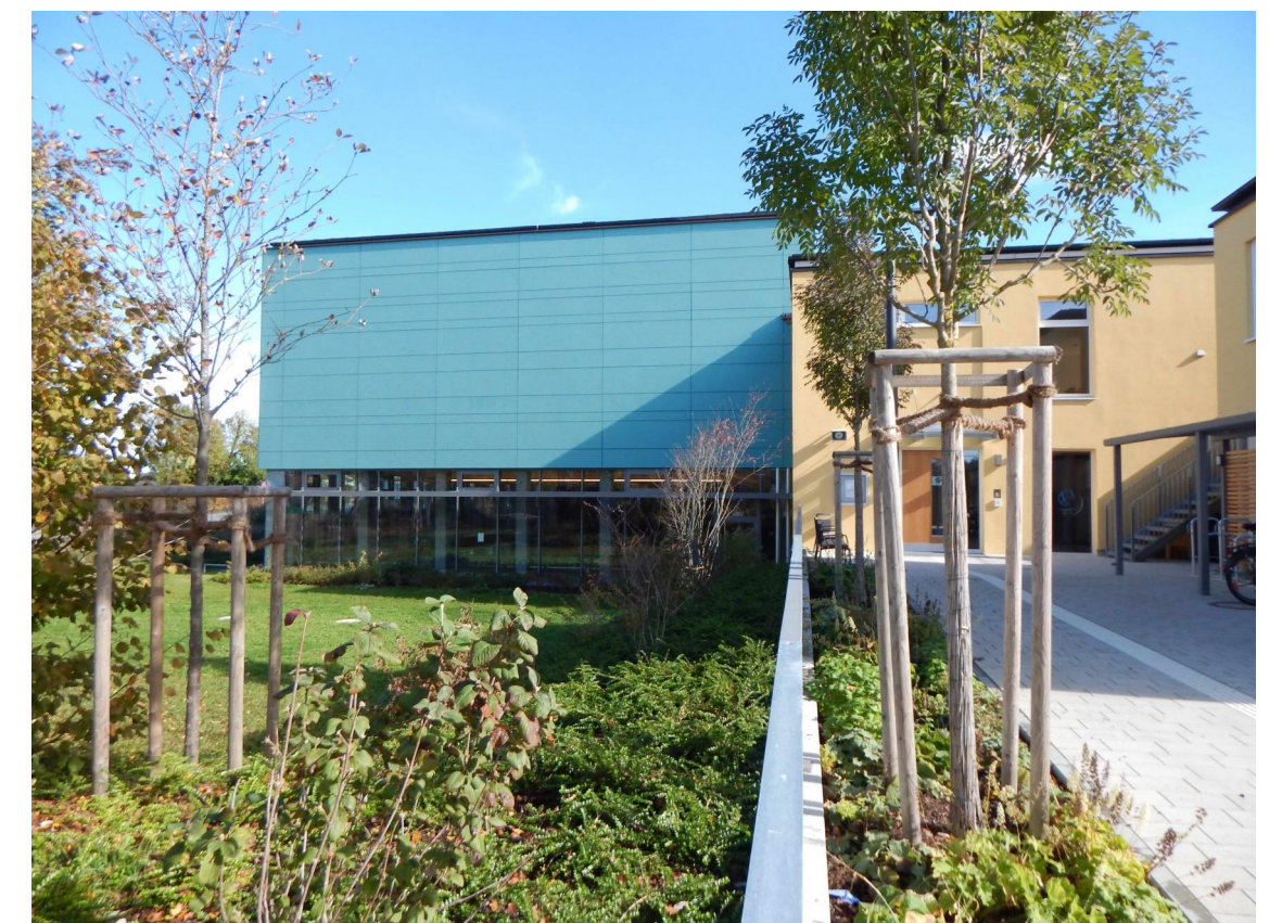
neuer Zugang Schwimmhalle © Schmuck
