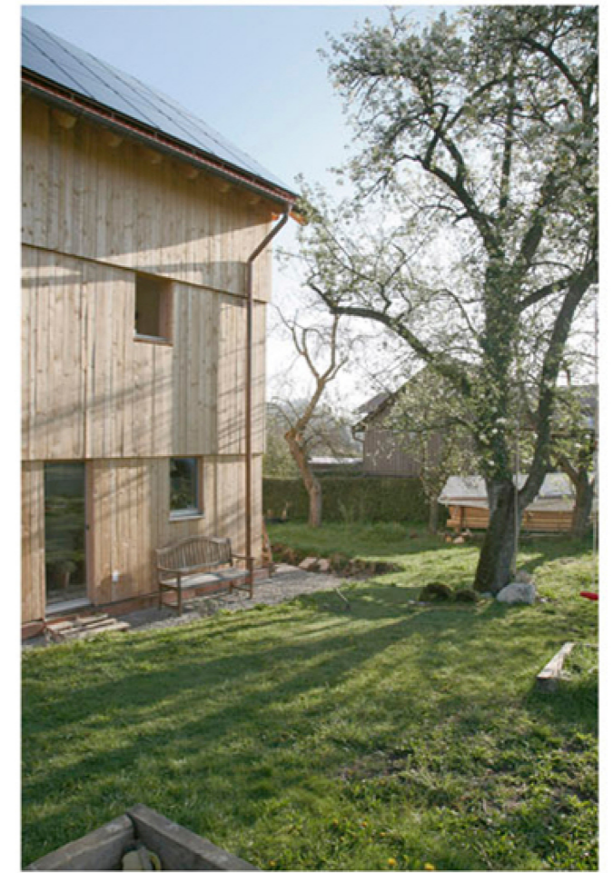
Regional Bauen Regionales Konstruktionsholz, Brettschalung aus Familienwald Regionaler Baukultur und Gestaltung beitragen, regionales Handwerk fördern
