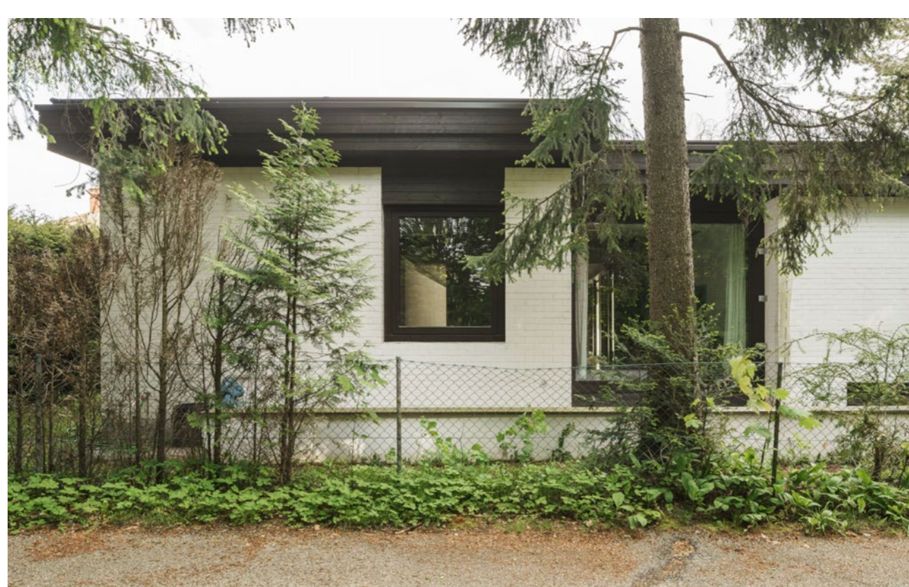
Dach und Fensterdetail © Benjamin Eder
