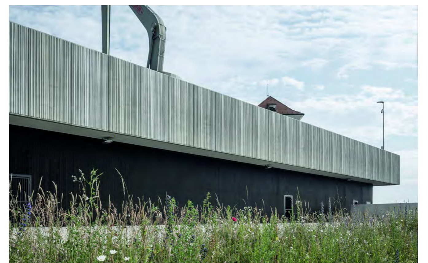
Einlaufbauwerk © Rainer Taepper
