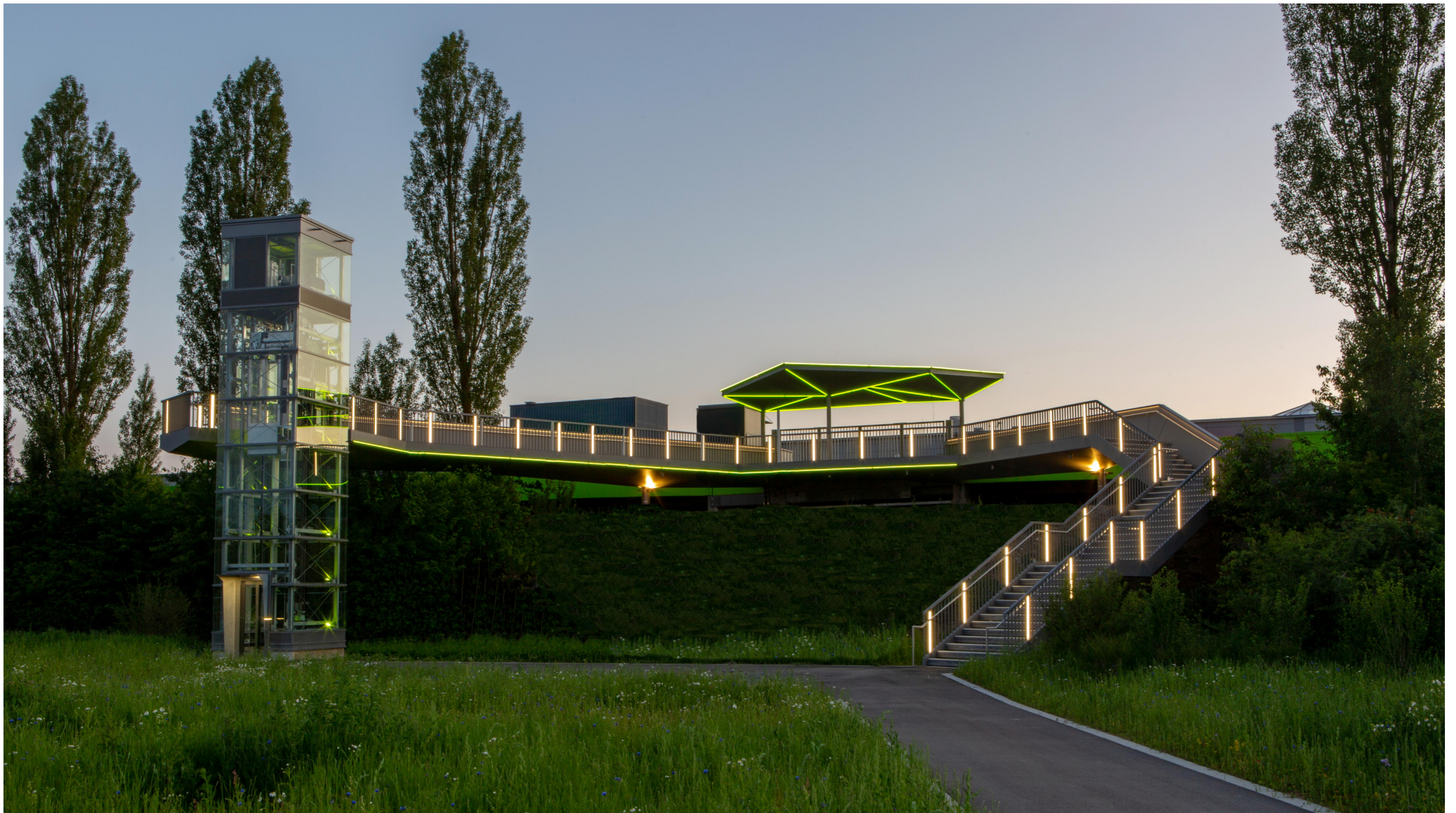
Ansicht von Osten © Stahlbau Schöpfer GmbH
