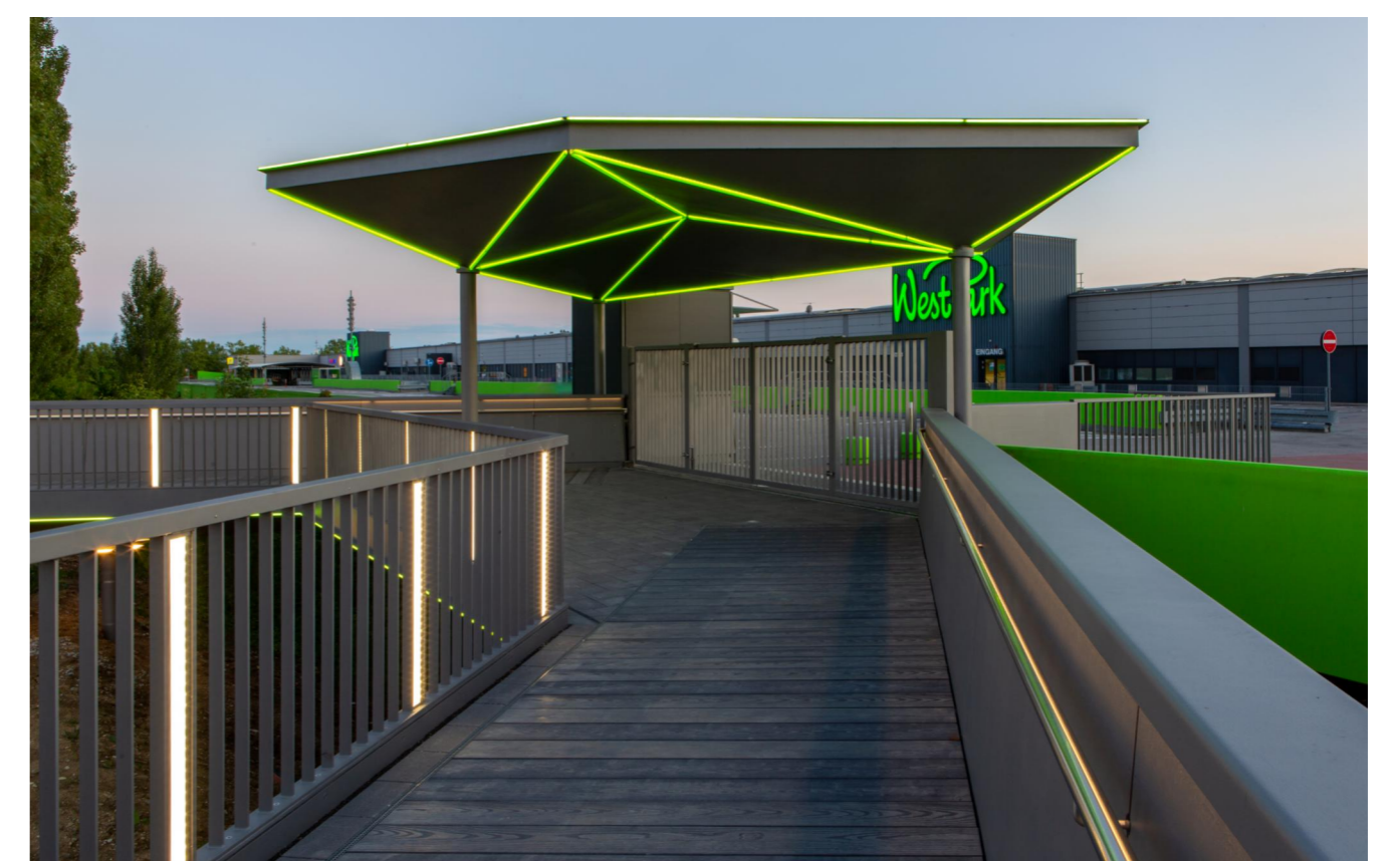
Detailsicht Zugang © Stahlbau Schöpfer GmbH
