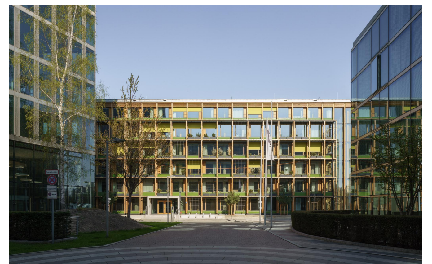
Fassadengestaltung © Sebastian Schels
